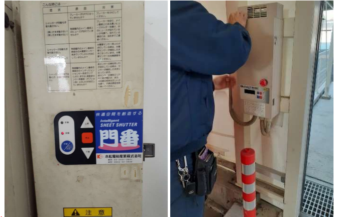
【シャッター制御盤に接続】
